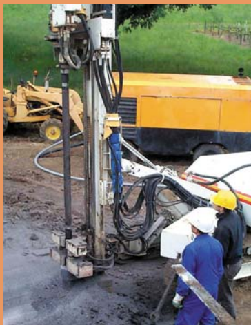
Pose d'une sonde géothermique
