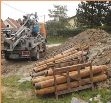
Mise en place d'un forage
