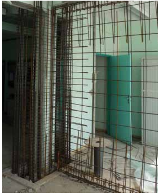
↳ Exemple de renforcement parasismique
