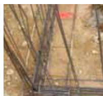
Noeud de chaînage - Continuité mécanique
